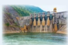
雷打滩水电站拥有三台水力发电机组, 总装机容量 10.8 万千瓦, 主要为弥勒磷电黄磷生产配套供应电力。
